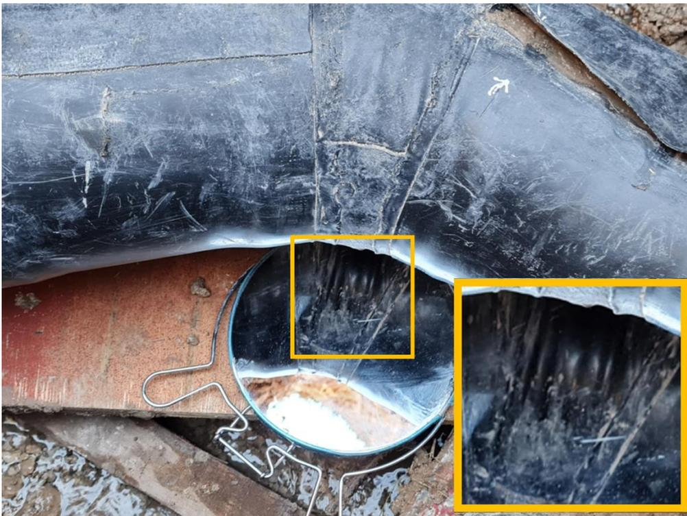
Figura 16: Uso incorrecto de una manta termocontraíble sobre un accesorio. Se observan arrugas en la parte inferior del codo.
