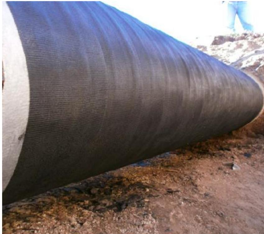
*Figura 23: Aplicación de cinta externa.*
