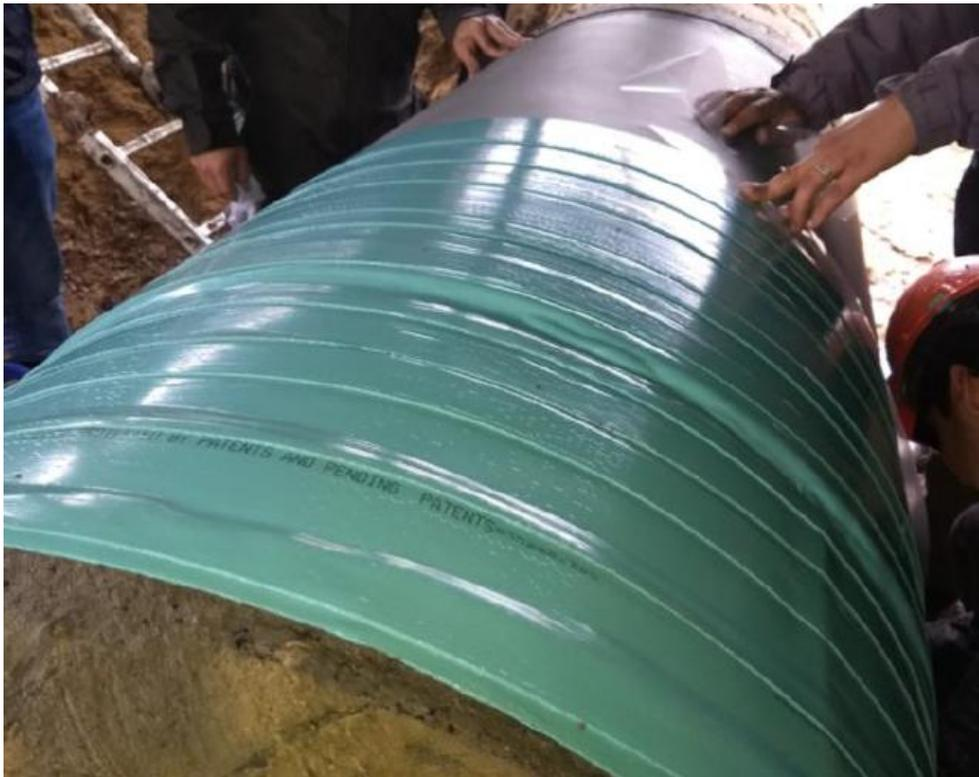
*Figura 24: aplicación de cinta viscoelástica.*
