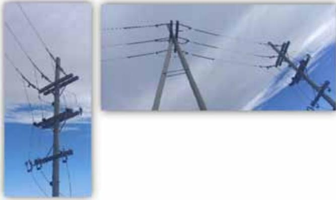
Fotos 3 y 4. **vista de cobertores colocados en cables de líneas eléctricas.**
