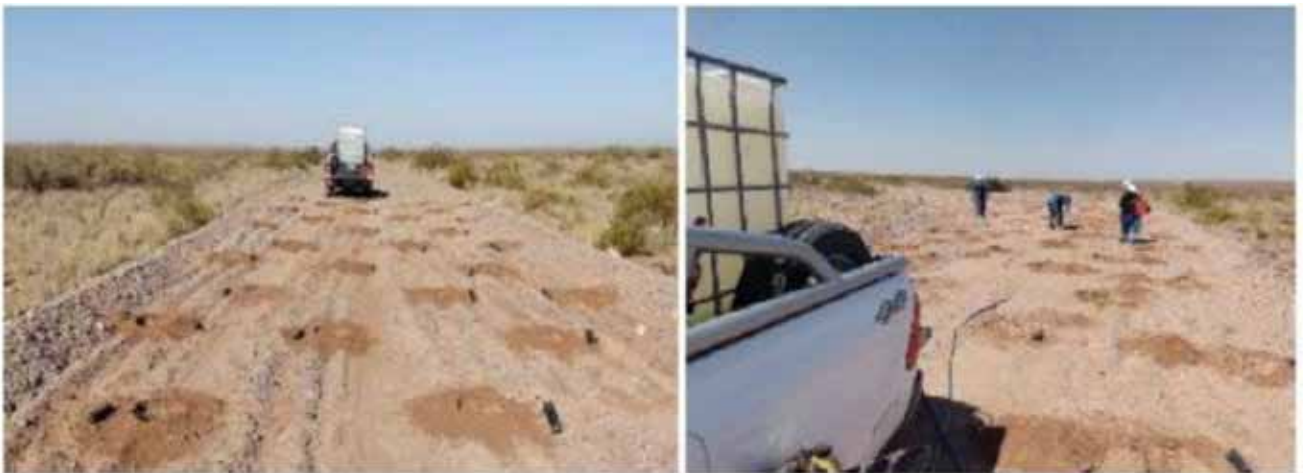
Fotos 10 y 11. Desarrollo de los trabajos de revegetación llevados a cabo en La Calera.
