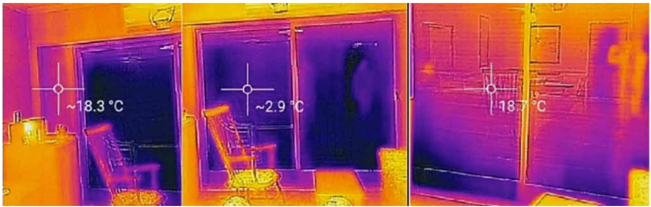
Figura 6. Fotos termográficas de una ventana. Izquierda: medición de la temperatura de la pared (18,3 °C). Medio: temperatura de la superficie del vidrio (2,9 °C). Derecha: temperatura del vidrio una vez que se cierra la persiana de madera (18,7 °C).
