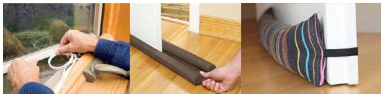
Figura 5. Ejemplo de diferentes tipos de burlete, izquierda en ventana y derecha en puertas.
