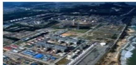
PETRONAS LNG Complex (PLC), Bintulu
