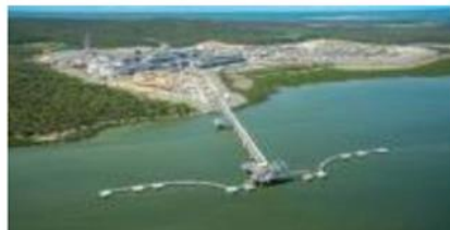
Gladstone LNG, Australia
